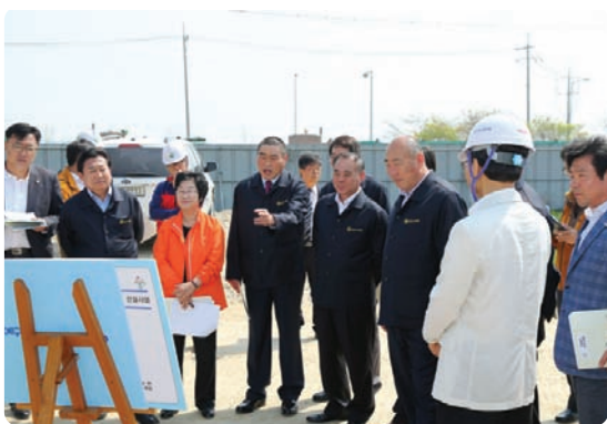
▶ 변전소 건설 현장 확인 점검
